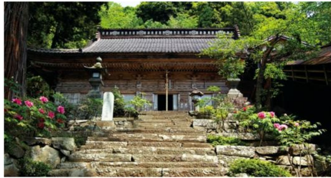
観音堂(十一面観音安置)
